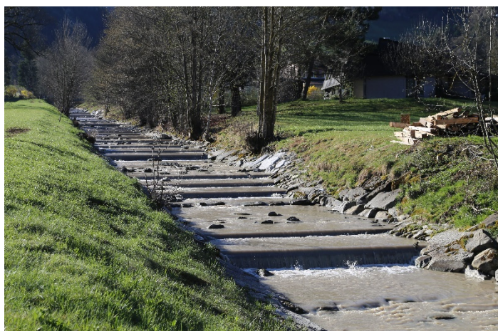
Fig. 19: Piccola opera di sistemazione a gradinate (esempio Steiglebach, Comune di Marbach, LU): sinistra foto, destra piano della situazione. (Fonti: Kanton Luzern, DS Verkehr und Infrastruktur (vif), Abt. Naturgefahren; Ufficio federale di topografia swisstopo: geoportale federale)
